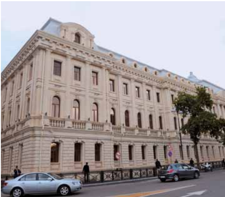
Bakıdakı 132-134 nömrəli təhsil kompleksi əsaslı yenidənqurmada sonra (2010)
